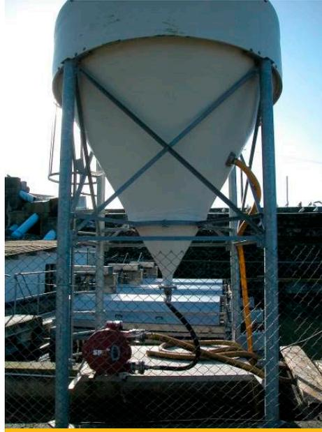
Ilustración 23. Sedimentador.
